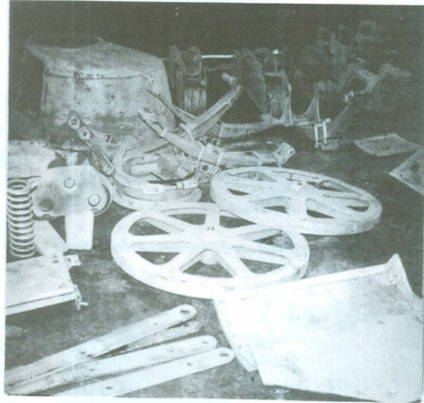
↑ Het loopwerk in onderdelen, met op de achtergrond de gedemonteerde toren.
